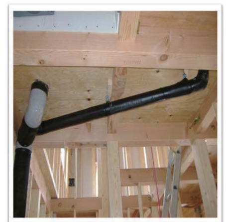
■ 排水管遮音完工圖
